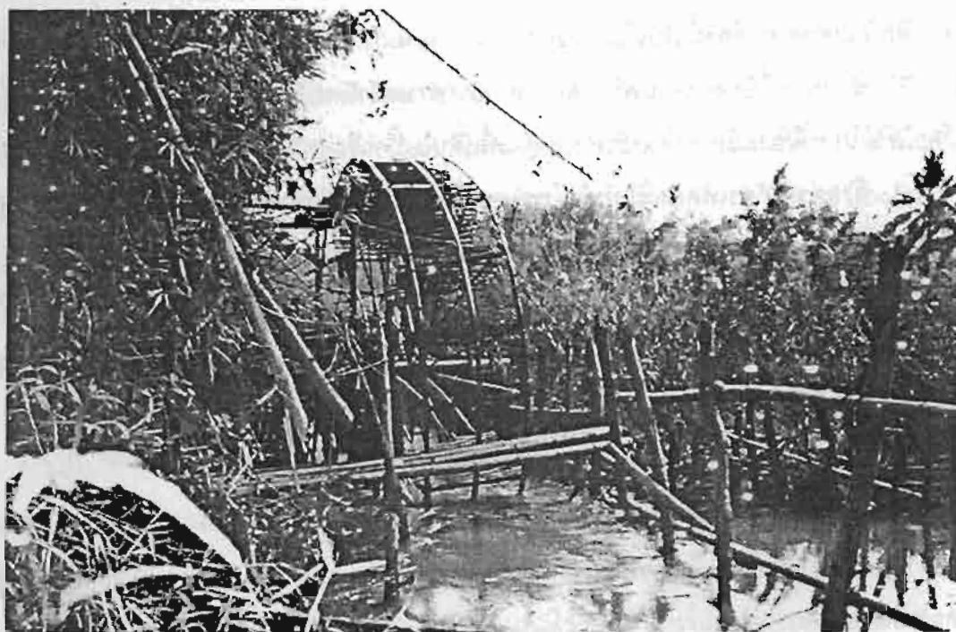
พืดหรือระหัดวิดน้ำ ภูมิปัญญาท้องถิ่นวัฒนธรรมลุ่มแม่น้ำห้วยบน
