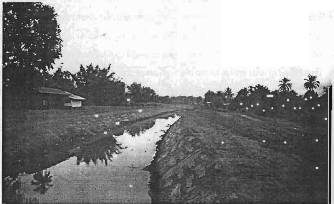
สภาพลำน้ำห้วยช่วงไหลผ่านบ้านนาเวียง กำลังได้รับการขุดลอก
