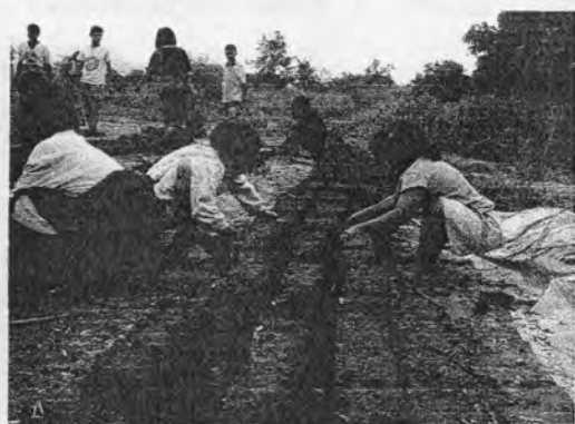
ตากก้อนดินให้แห้งก่อนนำไปก่อสร้างบ้านดิน
