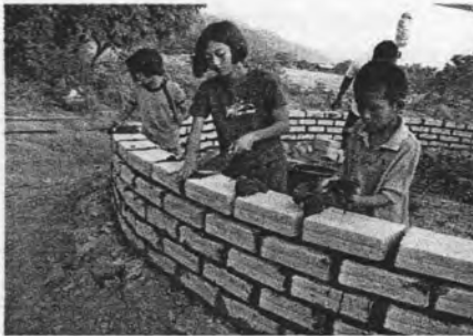
สร้างบ้านพักด้วยดิน ที่ศูนย์ฯสวนฝัน
