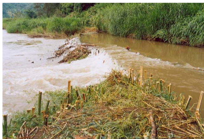
รูปที่ 6.34 ฝายไม้ที่เจ้าของนาในหุบเขาบ้านไร่ช่วยกันสร้าง
