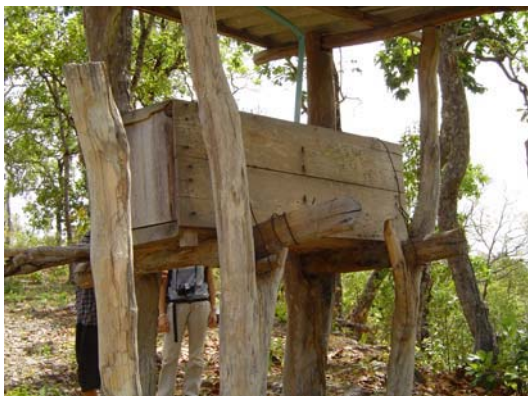
รูปที่ 3.33 โครงสร้างไม้บนยอดเขา
