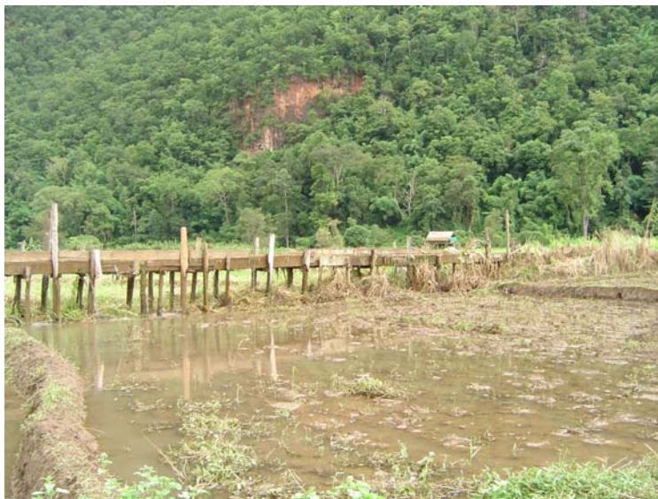
รูปที่ 4.4 รางไม้ที่ใช้แทนลำเหมืองส่งน้ำ
