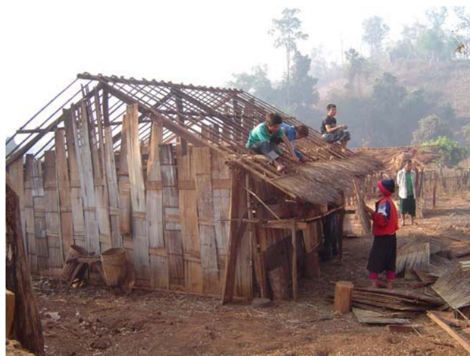
รูปที่ 6.22 เด็กหนุ่ม ๆ ช่วยกันมุงหลังคาบ้านใหม่
