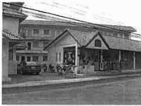
ร้านค้า อาคารพาณิชย์ในหมู่บ้าน
