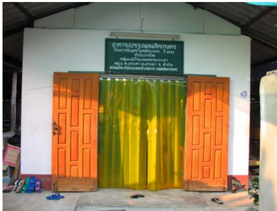
รูปที่ ก.9 โรงเรือนบรรจุ
