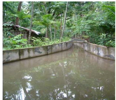
รูปที่ ก.4 บริเวณฝายชลประทาน
