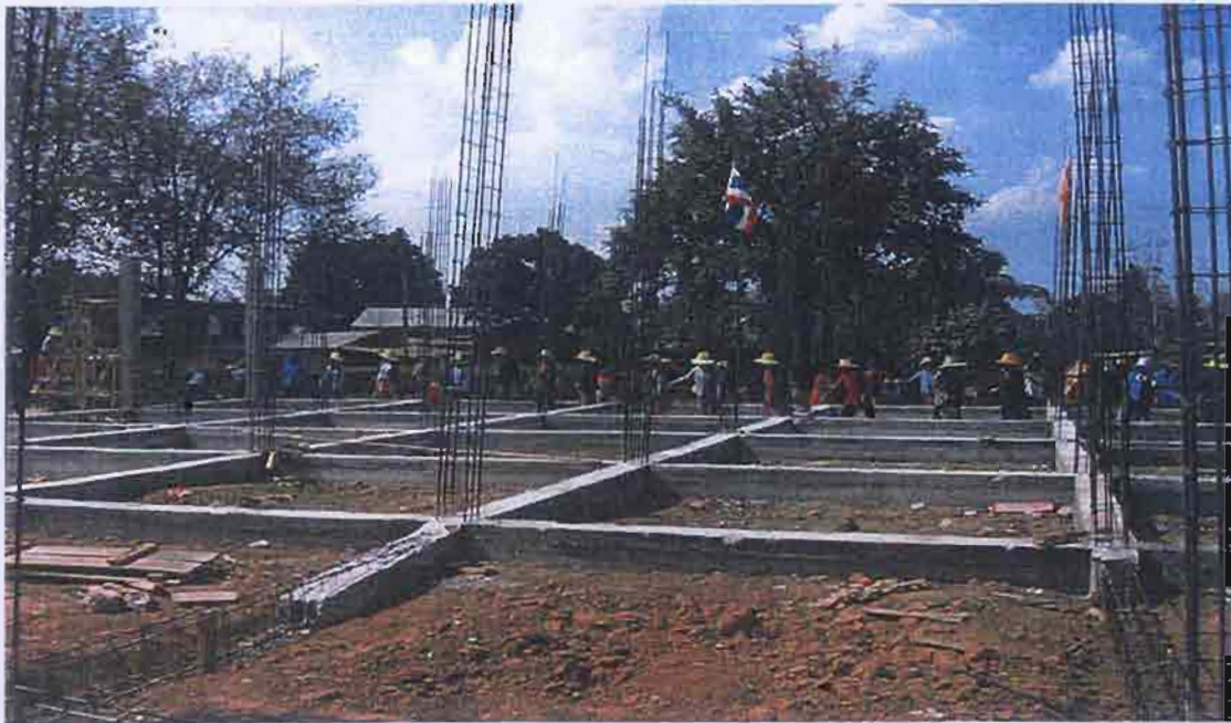
วัดสระแก้ว : ชาวบ้านรวมพลังกับพระ ช่วยการสร้างอาคารภายในวัด ในช่วงที่ชาวบ้านว่างเว้นจากการทำไร่ทำนา จะมาร่วมแรงทำบุญสร้างวัด
