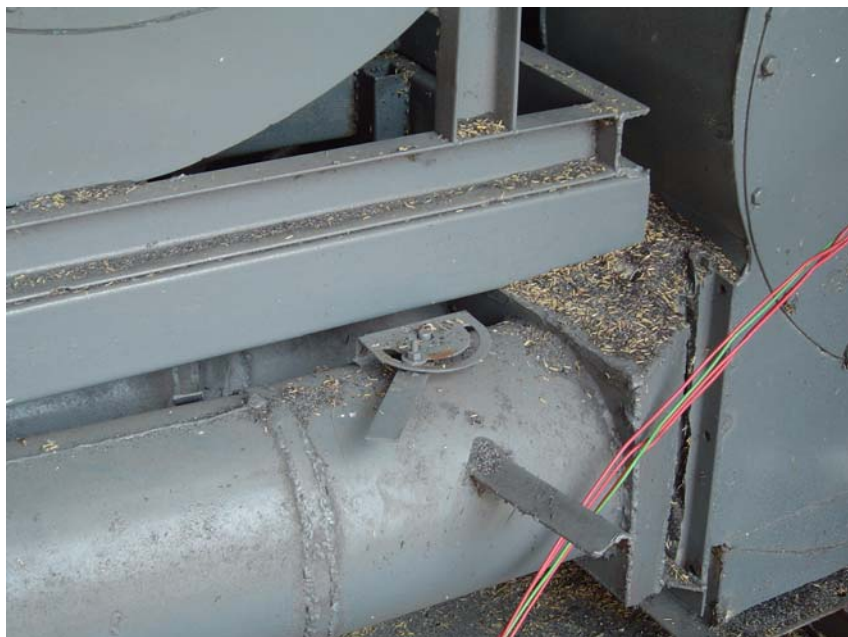
รูปที่ ค.9 แสดงตำแหน่งของวาล์วปีกผีเสื้อที่เกิดปัญหา
