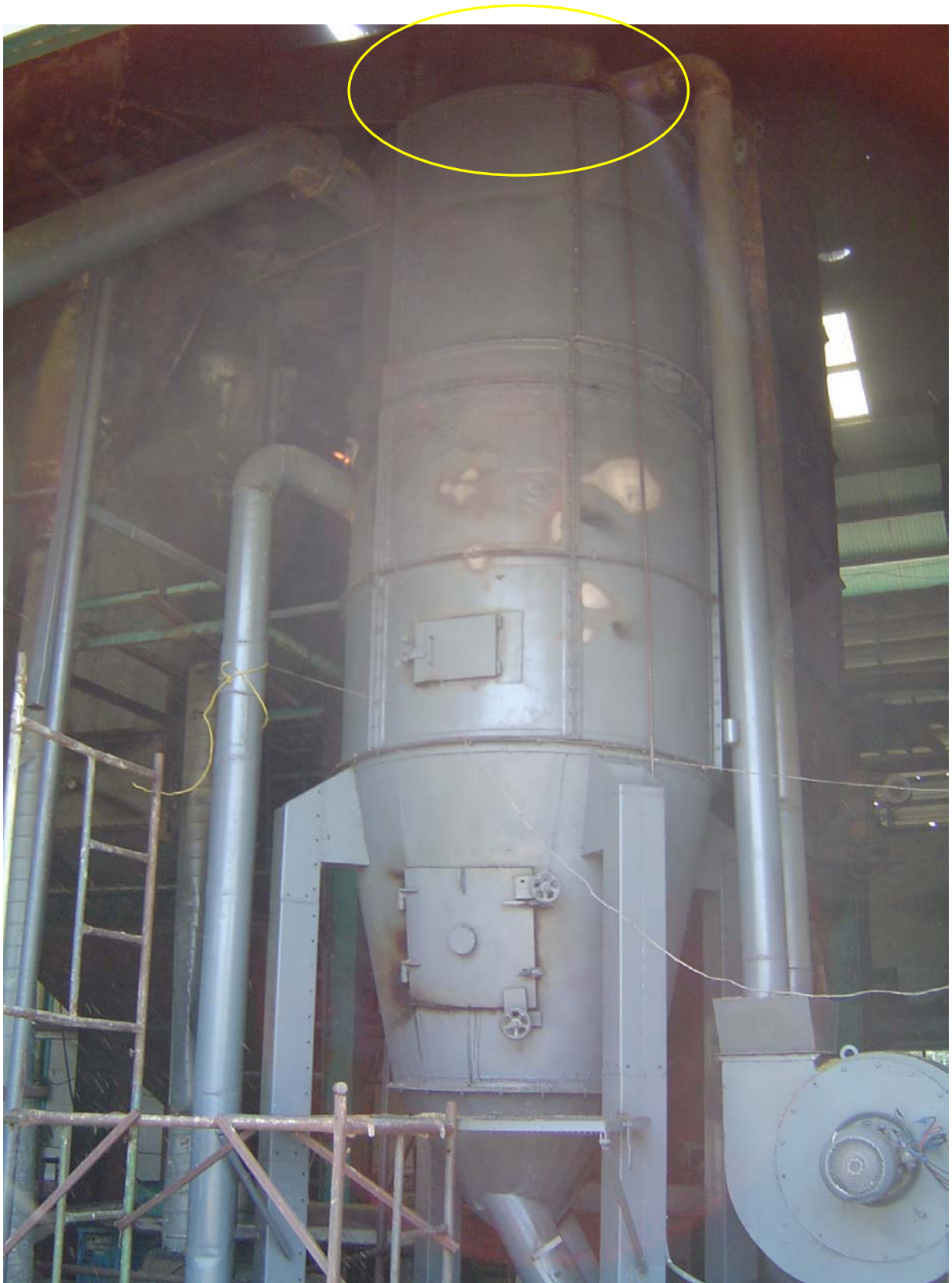
รูปที่ ค.12 แสดงกล่องผสมอากาศซึ่งช่วยลดอุณหภูมิแก๊สเผาไหม้
