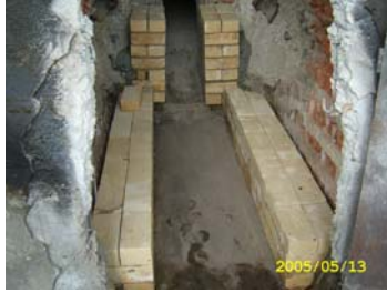
รูปที่ 4-8 ก่ออิฐทนไฟในเตาเผาเพิ่มเติมจากอิฐเดิมที่ชำรุด
