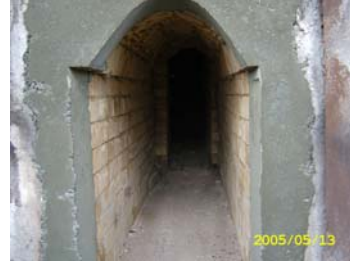
รูปที่ 4-8 ก่ออิฐทนไฟในเตาเผาเพิ่มเติมจากอิฐเดิมที่ชำรุด
