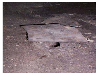
รูปที่ 7 ท่อให้ความร้อนของเตาเรือนปี 2537 ฝาครอบลอยขึ้นมาปากท่อ
