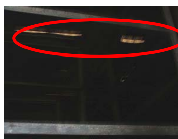
รูปที่ 4-1 ฝ้าเพดานที่มีรอยร่วความร้อนไหลออกได้
