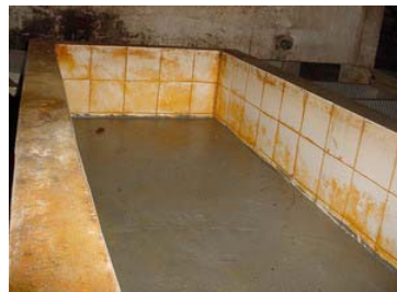
รูปที่ 4-3 รางลำเลียงยางของสหกรณ์คอนขี้เหล็ก เทพื้นให้ความลึกของรางเหลือเพียง 40 เซนติเมตร
