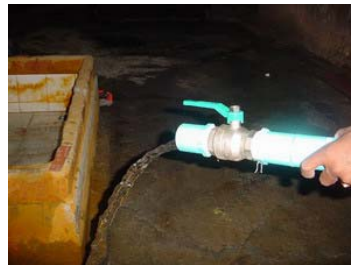
รูปที่ 4-6 ติดวาล์วปิดเปิดน้ำ
