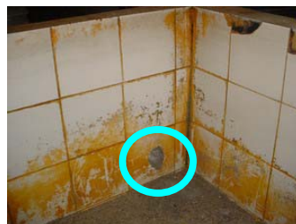
รูปที่ 6 รูที่เจาะเพื่อนำน้ำไปใช้ล้างพื้น
