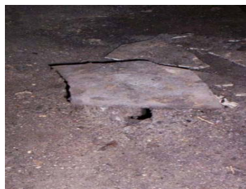
รูปที่ 3-24 การทำฝาครอบลอยขึ้นมาปากท่อ เพื่อให้ความร้อนออกมาไม่มากเกินไป
