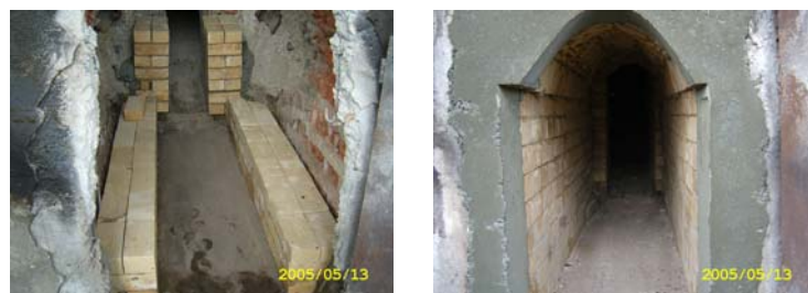
รูปที่ 14 ก่ออิฐทนไฟในเตาเผาเพิ่มเติมจากอิฐเดิมที่ชำรุด
