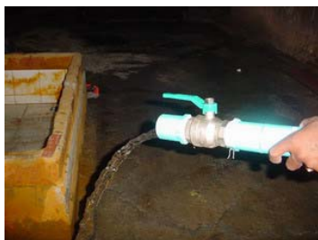
รูปที่ 3 ติดวาล์วปิด-เปิดน้ำ
