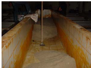
รูปที่ 4-3 รางลำเลียงยางของสหกรณ์คอนขี้เหล็ก เทพื้นให้ความลึกของรางเหลือเพียง 40 เซนติเมตร
