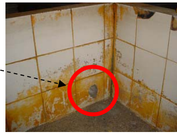
รูปที่ 3-14 รูที่เจาะเพื่อนำน้ำไปใช้ล้างพื้น
