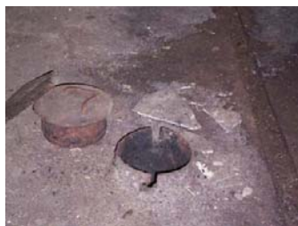
รูปที่ 7 ท่อให้ความร้อนของเตาเรือนปี 2537 ฝาครอบลอยขึ้นมาปากท่อ
