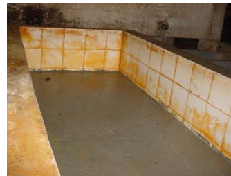
รูปที่ 5 รางลำเลียงยางของสหกรณ์ดอนชีเหล็ก เทพื้นให้มีความลึกของรางลดลง
