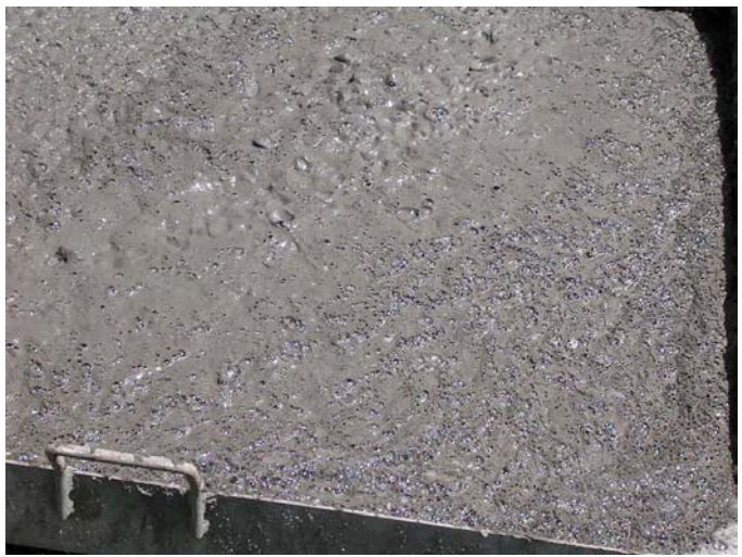
รูปที่ 2 ฟองอากาศจำนวนมากในคอนกรีตที่ W/C = 0.6 ผสมน้ำยา
