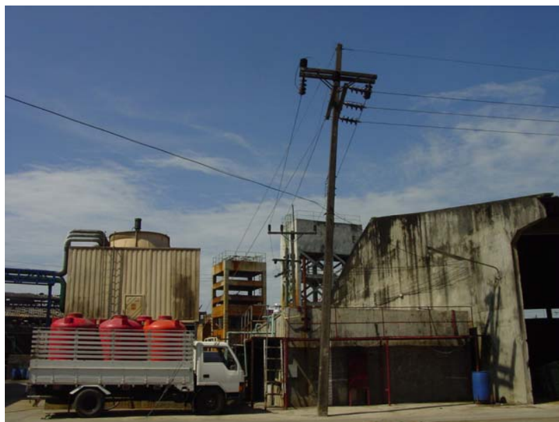
ภาพที่ 6: การลำเลียงน้ำทิ้งจากโรงงานปลาป่นในเขตโรงงานอุตสาหกรรมจังหวัดปัตตานี
