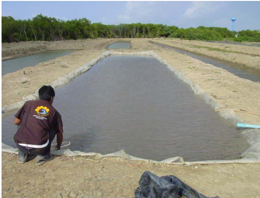
ภาพที่ 9: บ่อผลิตไรวุ้นน้ำเค็ม มีขนาดความจุของปริมาตรน้ำประมาณ 200 ลูกบาศก์เมตร
