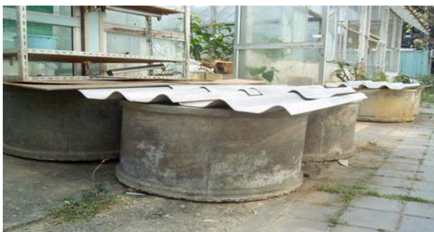
ภาพ 5 บ่อซีเมนต์กลมที่ใช้เก็บน้ำทิ้งจากโรงอาหาร
