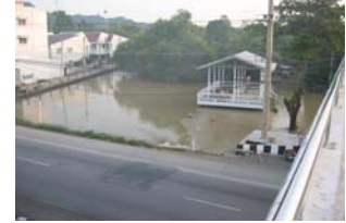
ข. คลองชลประทานเขาตะเครา: ระดับน้ำแตกต่างเนื่องจากขนาดช่องเปิดไม่เพียงพอ
