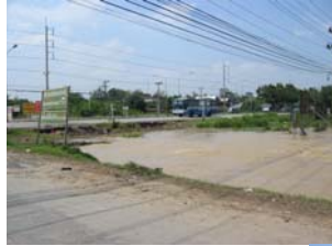
ข. คลองชลประทานเขาตะเครา: ระดับน้ำแตกต่างเนื่องจากขนาดช่องเปิดไม่เพียงพอ
