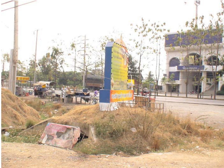
รูปที่ 7-12 ตัวอย่างทางคนเดินลดบบริเวณหน้าตลาดเขาย้อยที่ก่อสร้างค้างไว้
