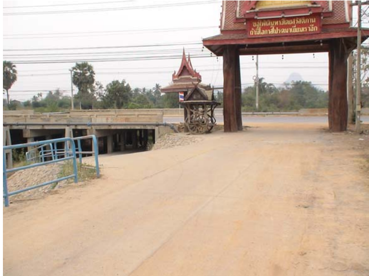
รูปที่ 7-8 ตัวอย่างทางลอดที่เชื่อมกับถนนหมู่บ้านตามแนวคันคลอง
