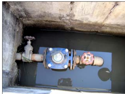
รูปที่ 3 ดูงาน เรื่องการชลประทานระบบท่อ มีมิเตอร์ไว้ในนาข้าว จ.ขอนแก่น
