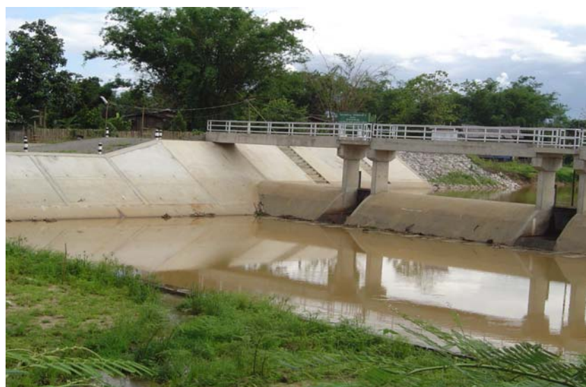
ภาพที่ 7 ภาพแสดงตะกอนทับถมบริเวณฝาย
