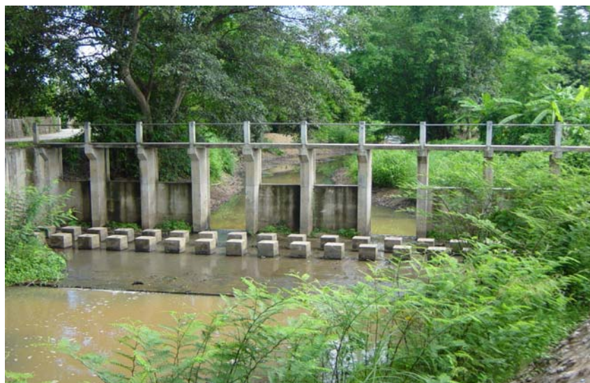
ภาพที่ 12 ภาพแสดงการตื้นเขินของหน้าฝาย
