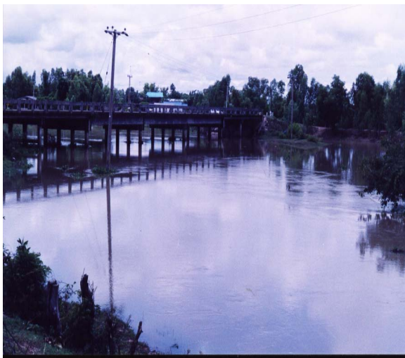
ลำน้ำเสียวใหญ่ บริเวณสะพานกุ่าสิงห์
