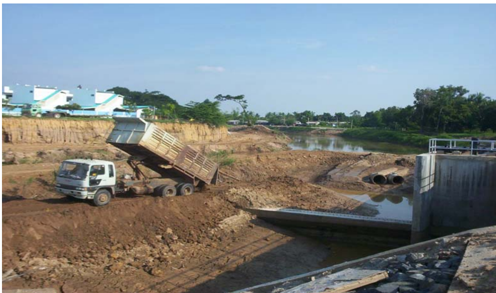
“ภาพที่ 36 การก่อสร้างฝายน้ำล้น แบบฝายยาง ปิดกั้นลำน้ำป่าวบริเวณ ถนนเลี่ยงเมืองด้านใต้จังหวัดกาฬสินธุ์
