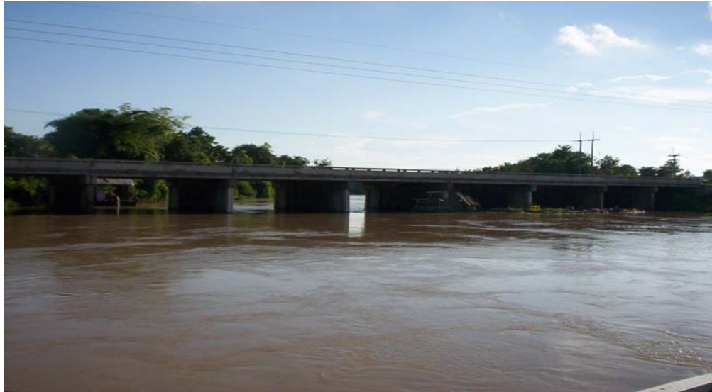
“ภาพที่ 31 สะพานข้ามแม่น้ำปาวพื้นที่ อ.กมลาไสย และ อ.ร่องคำ”
