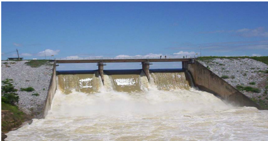
“ภาพที่ 20 ช่อระบายน้ำทิ้ง กรณีน้ำมากเกินไปปริมาณการกักเก็บของเขื่อน ;เขื่อนลำปาว”
