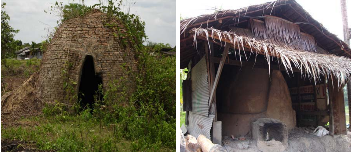
แผนภาพ 2.3 ลักษณะของเตาเผาถ่านขนาดเล็กที่ทำจากอิฐแดง
