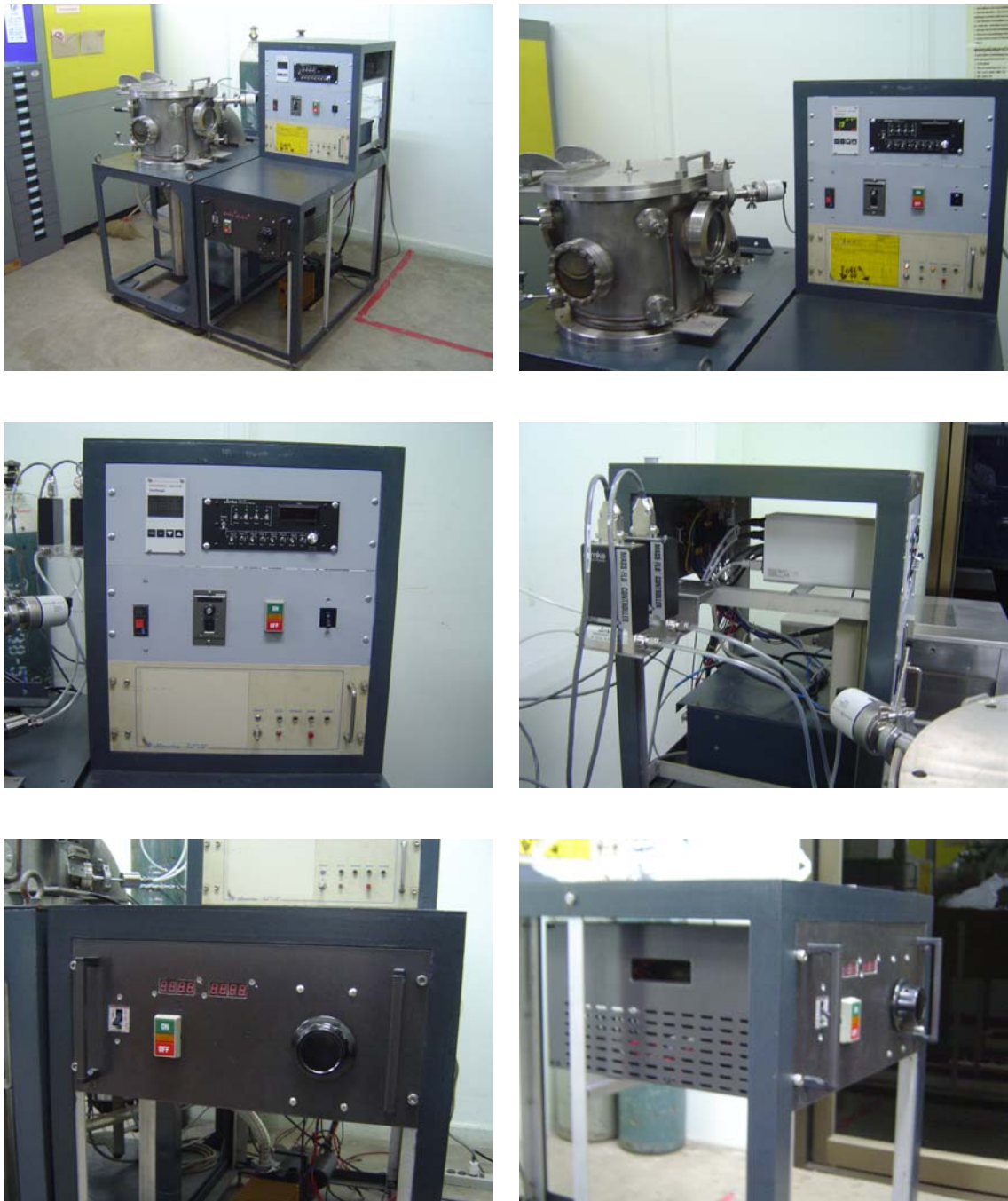
รูปที่ 4-15 ลักษณะตู้ควบคุมหลักของเครื่องเคลือบ
