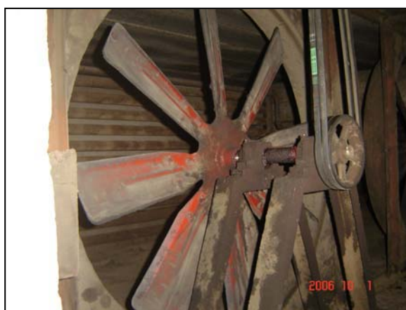
ภาพที่ 7.12 ลักษณะของการติดตั้งพัดลม
