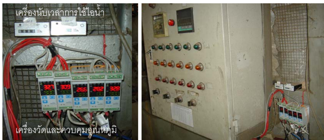
ภาพที่ 7.3 การติดตั้งเครื่องวัดและควบคุมอุณหภูมิ Shinko DCL-33A R/M,C5 และเครื่องนับเวลาการใช้ไอน้ำ NaiS TH648
