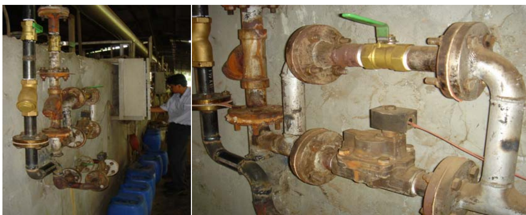
ภาพที่ 7.8 การติดตั้งโซลินอยด์วาล์วที่ท่อคอยล์ร้อนและท่อสเปร์ย์
