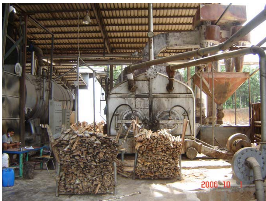
ภาพที่ 7.14 หม้อต้มไอน้ำที่ใช้ในโรงงาน
