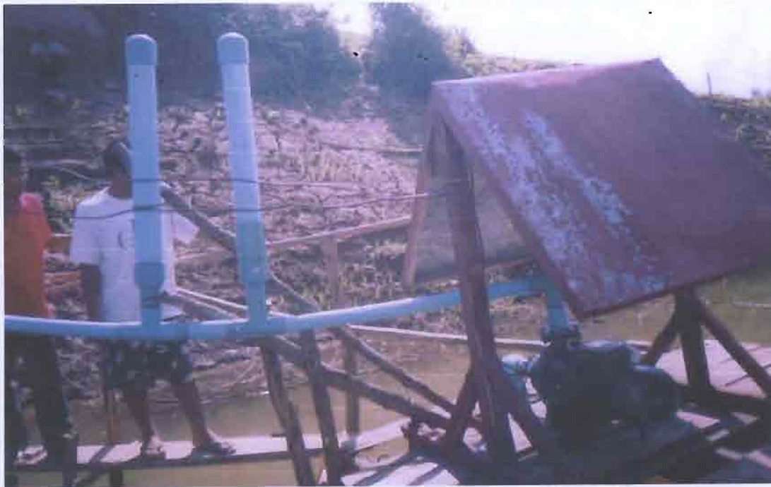
การติดตั้งระบบ แอร์แวน และมีแนวคิดที่จะทดลองทำเพิ่มขึ้นเป็น4 ท่อ
