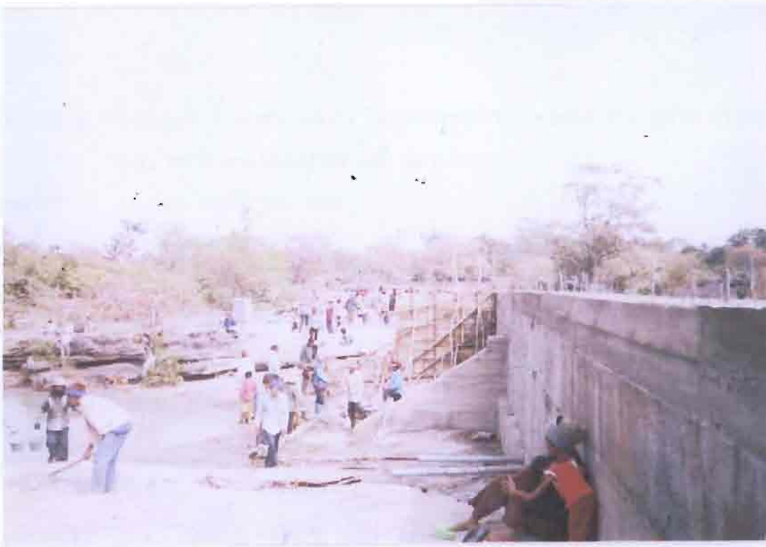
ต่อเติม และทำความสะอาดฝาย
