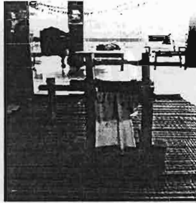
นำไปบิด(หนีบ)ด้วยเครื่องหนีบเพื่อเอาเมล็ดฝ้ายออก
