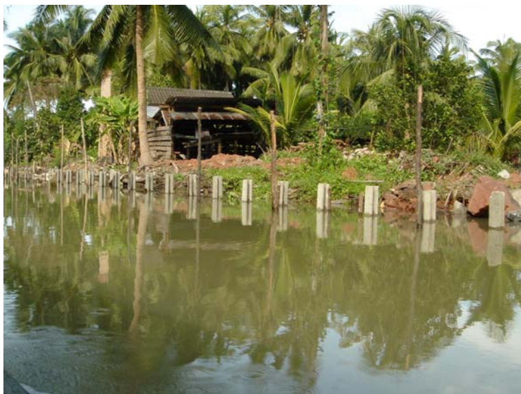
ภาพที่ 4.32 แสดงภาพรูปแบบเขื่อนเข็มพืดกำลังก่อสร้างเพิ่มเติมที่พบในพื้นที่
