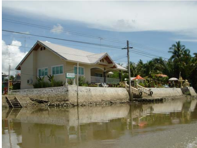
ภาพที่ 4.33 แสดงภาพรูปแบบเขื่อนโครงสร้างเอียงที่พบในพื้นที่
