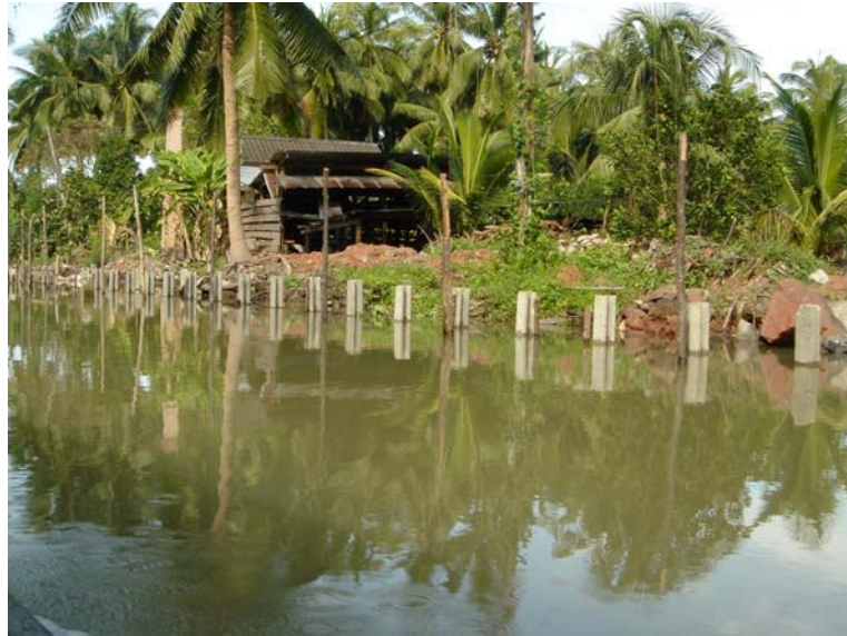
ภาพที่ 4.32 แสดงภาพรูปแบบเขื่อนเข้มน้ำกัดกำลังก่อสร้างเพิ่มเติมที่พบในพื้นที่
