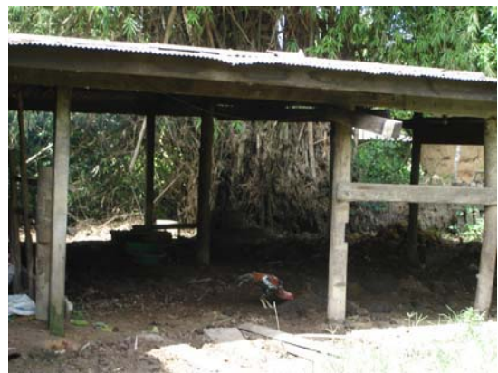
ภาพที่ 2.8 คอกเลี้ยงโคพื้นเมืองแบบหลังคามุงสังกะสี ไม่เทพื้นคอก
