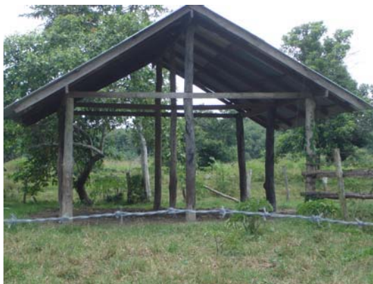
ภาพที่ 2.9 คอกเลี้ยงโคพื้นเมืองแบบหลังคามุงกระเบื้อง ไม่เทพื้นคอก
