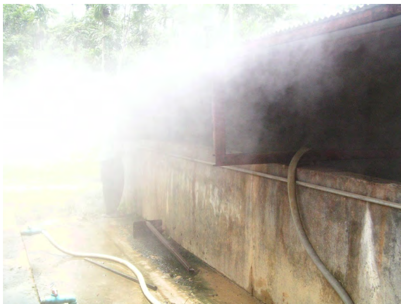
รูปที่ 5.6 ตัวอย่างบ่อเก็บคอนเดนเสทของโรงงานอบไม้ยางพารา
