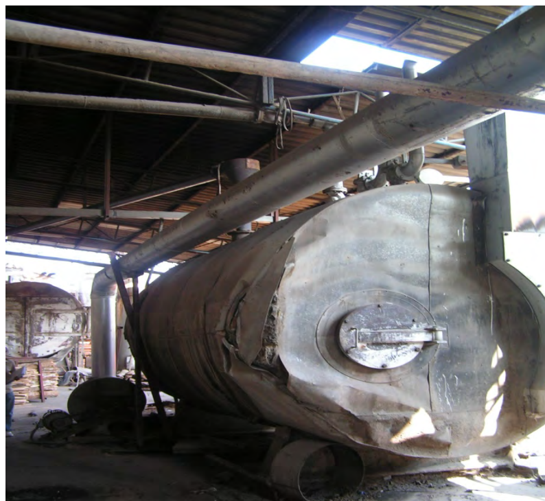
รูปที่ 5.5 ตัวอย่างสภาพหม้อไอน้ำของโรงงานอบไม้ยางพารา
