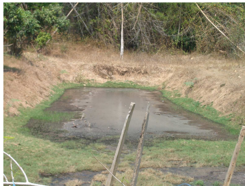
ภาพที่ 5 บ่อพักน้ำเสีย
