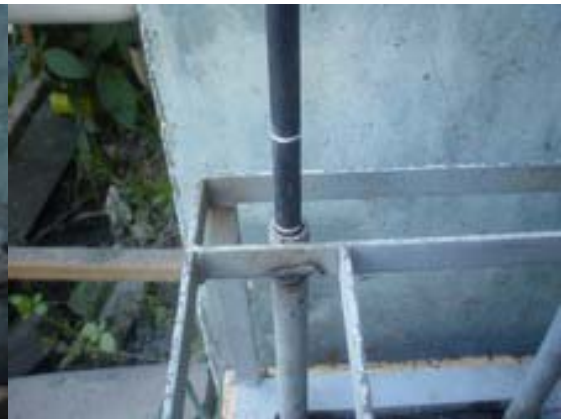
(ง) ตรวจสอบว่าเหล็กที่ฝังอยู่ในตำแหน่งที่ต้องการ
