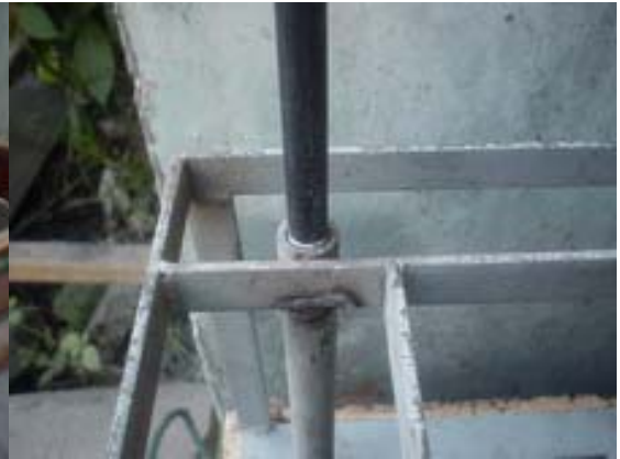
(ข) ใช้เหล็กนำร่องเพื่อดันคอนกรีตให้เกิดช่องว่าง
