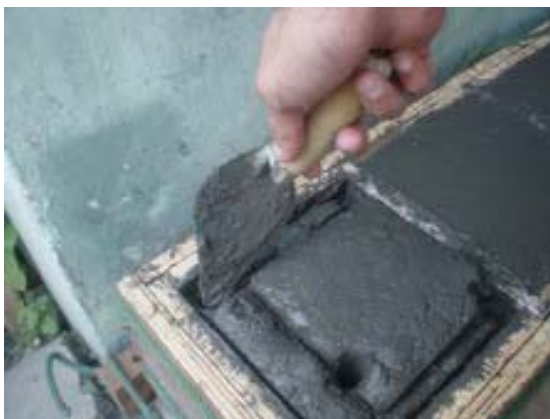
(จ) ใช้เกรียงเกลี่ยคอนกรีตสดให้เต็มแบบหล่อ
