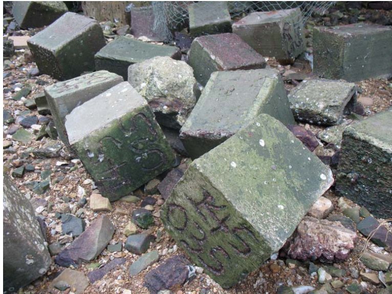
รูปที่ 4.9 สภาพผิวคอนกรีตที่ผสมเถ้าถ่านหินแม่เมาะที่ผ่านการแช่น้ำทะเลเป็นเวลา 5 ปี
