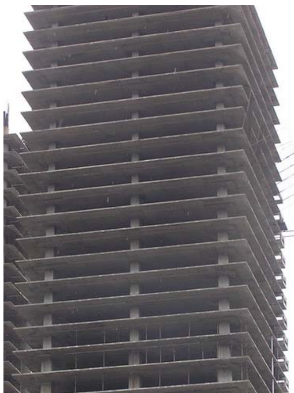
รูปที่ 2.21 ระบบพื้นแผ่นเรียบไร้คาน (Solid Flat Slab)
