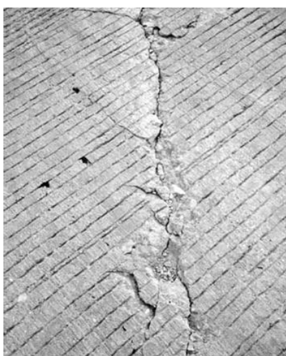
Spalling
