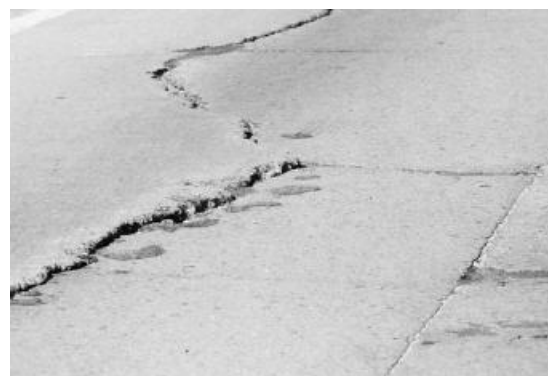
Longitudinal Crack
