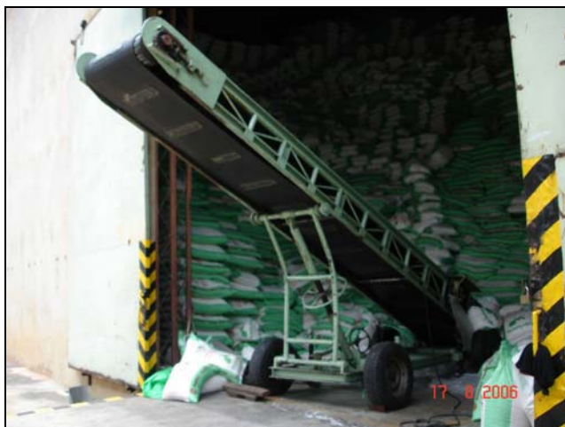
รูปที่ 3.8 สายพานลำเลียงน้ำตาลขึ้นรถบรรทุก (โรงงานน้ำตาลอุทุมพรพิสัย)
