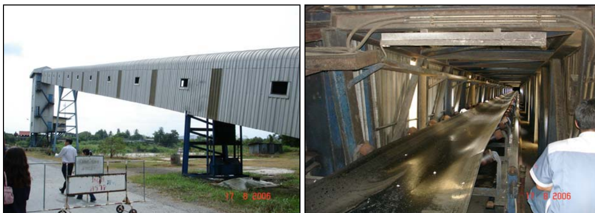
รูปที่ 4.10(1) และ (2) เครื่องลำเลียงน้ำตาลแบบเทกองจากคลังลงสู่เรือโป๊ะ
