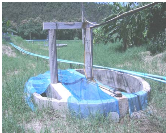
ข. บ่อรวบรวมน้ำเสียก่อนหมัก
