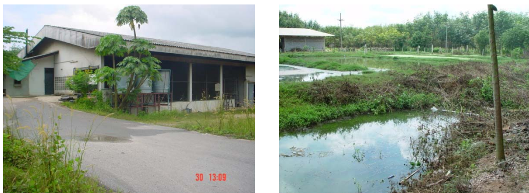
รูปที่ 3-2 การสำรวจและคัดเลือกสหกรณ์ที่จะติดตั้งระบบบำบัด
