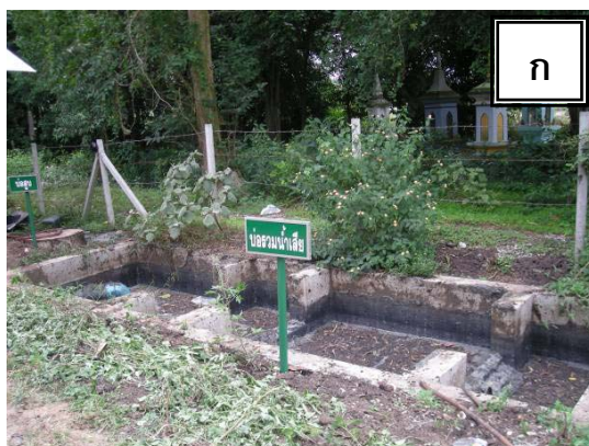
รูปที่ 2-1 ลักษณะของบ่อรวมน้ำเสียของสหกรณ์โรงอบ/รมยางทอง (ก) และ จุดที่ใช้สูบน้ำเสียเข้าระบบ (ข)
