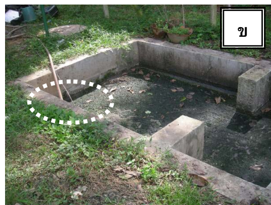
รูปที่ 2-1 ลักษณะของบ่อรวมน้ำเสียของสหกรณ์โรงอบ/รมยางทอง (ก) และ จุดที่ใช้สูบน้ำเสียเข้าระบบ (ข)
