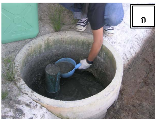
รูปที่ 2-8 การนำเชื้อจุลินทรีย์เริ่มต้นจากบ่อหมักมูลสุกรในฟาร์มสุกร (ก) และการเติมหัวเชื้อลงในระบบสำหรับเริ่มเดินระบบ (ข)
