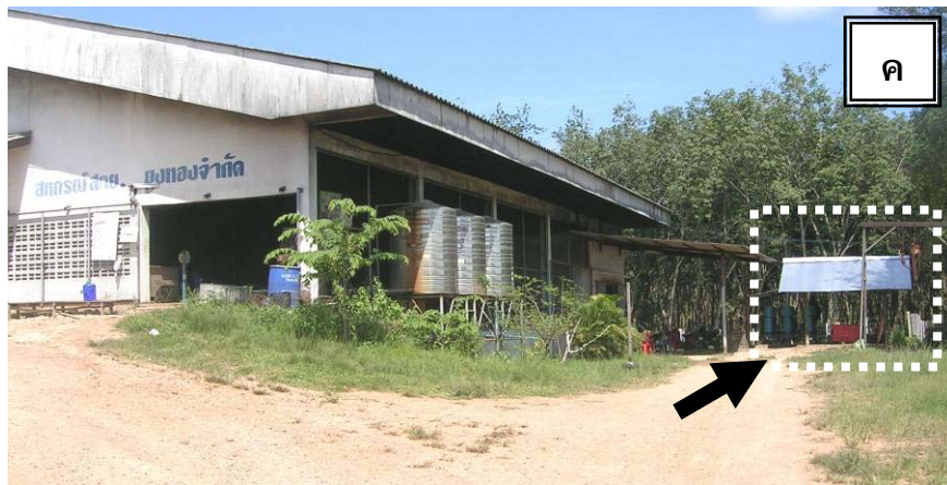
รูปที่ 2-3 โรงเรือนสำหรับติดตั้งระบบหมักไร้อากาศก่อนก่อสร้างโรงเรือน (ก), โรงเรือนสำหรับติดตั้งระบบหมักไร้อากาศ (ข) และตำแหน่งที่ตั้งโรงเรือน (ค) ณ สหกรณ์บ้านยูงทอง ต.ท่าช้าง อ.บางกล่ำ จ.สงขลา
