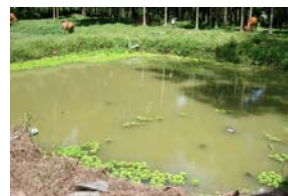
บ่อบำบัดน้ำเสียของโรงนม
