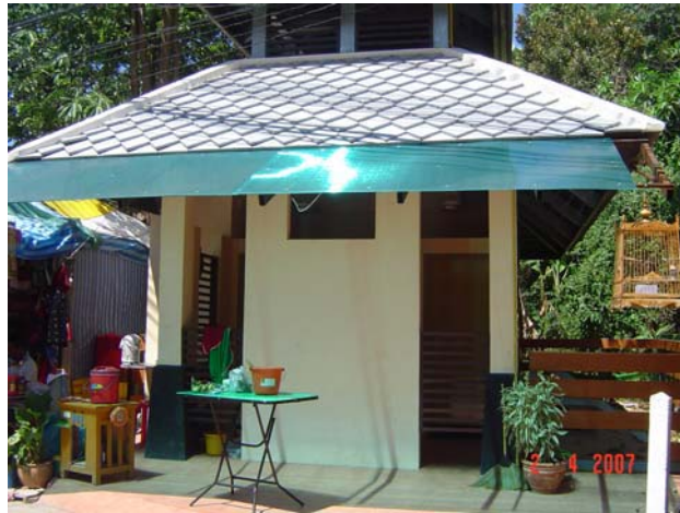
ภาพที่ 4.27 ห้องน้ำสาธารณะบริเวณหาดทรายขาว (ยังไม่เปิดให้บริการ 2 เม.ย. 50)
