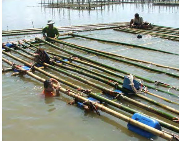
ภาพที่ 30 การทำแพลอยเพื่อใช้ในการทดลอง
