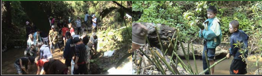
การทำฝายชะลอน้ำตามลำห้วยหลอด
