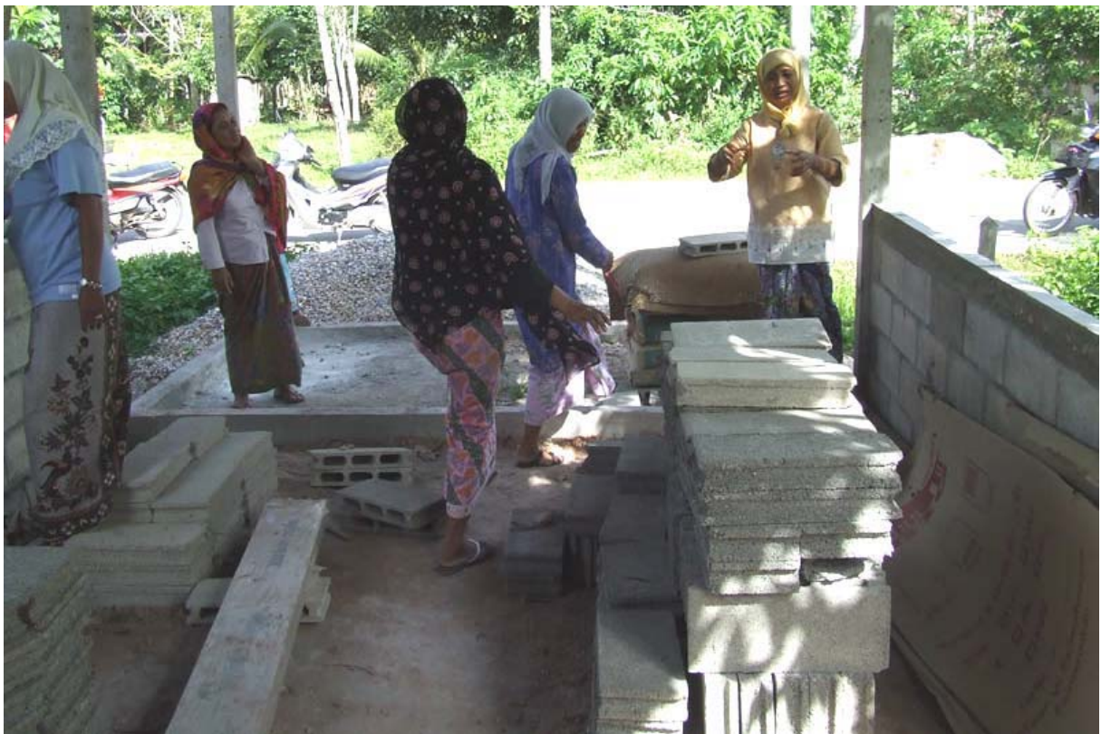
ร่วมแรงร่วมใจก่อสร้างศูนย์สาธารณสุขมูลฐานชุมชนบ้านนาค้อใต้ วันที่ 19 มกราคม 2550 ณ บ้านนาค้อใต้ ตำบลมะกรูด อำเภอโคกโพธิ์ จังหวัดปัตตานี
