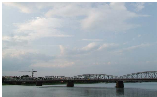
สะพาน โค้งครึ่งเดือน (Trang Tien)
