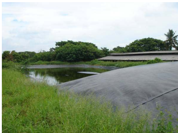
Biogas ชนิด cover lagoon
