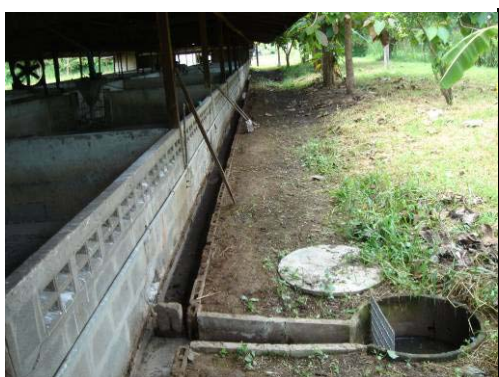
รางรับน้ำเสียจากโรงเรือนและไหลลงบ่อดักตะกอนก่อนไปใช้เป็น biogas
