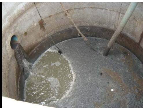
รางรับน้ำเสียจากโรงเรือนและไหลลงบ่อดักตะกอนก่อนไปใช้เป็น biogas
