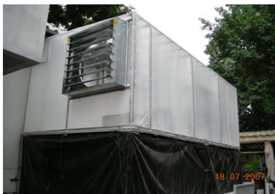
รูปที่ 4.1 โครงสร้างระบบโรงเรือนแบบไอระเหย (green evaporative room)
