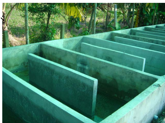
ภาพ 3.1 บ่อซีเมนต์ระบบน้ำวนใช้เพาะเลี้ยงสาหร่ายไถ
